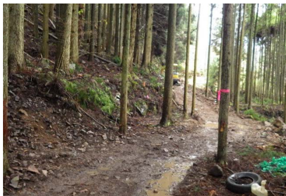
活動森林内で整備された森林作業道
