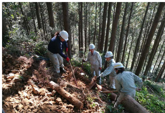
作業道路整備研修「木組み補強」の様子
